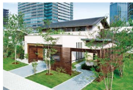
世界初となる太陽電池・燃料電池・蓄電池の3電池連動自動制御の住まいで、災害停電時にも自立した生活を可能とする「グリーンファーストハイブリッド」。横浜市みなとみらい21地区に立つスマートハウス「観環居」で、実証実験が行われている。
