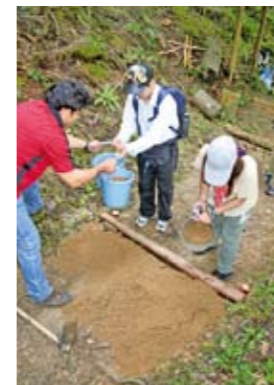
傷んだ路面に土を入れて補修
