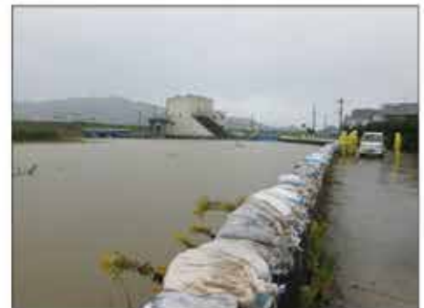
H29.10.20～23 台風21号 排水機での排水が追いつかず、土のう により道路への越水を辛うじて防いで いる（紀の川市）
