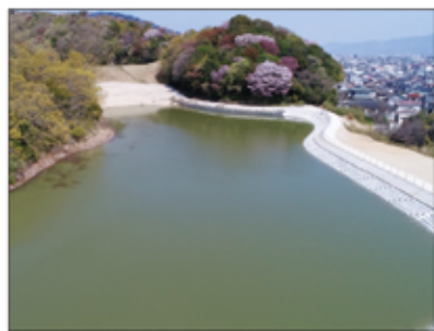
《全面改修》 （堤体・洪水吐・取水施設等整備）
