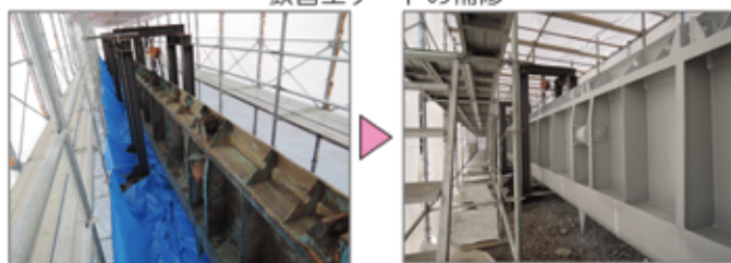
頭首工ゲートの補修
