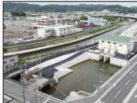
令和2年度供用した米田排水機場 （和歌山市）
