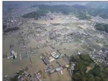
H24.6.21～22 集中豪雨 和た川流域での広範囲な冠水（和歌山市）
