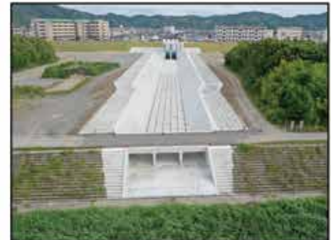
令和3年度完成の干旦樋門 （和歌山市）
