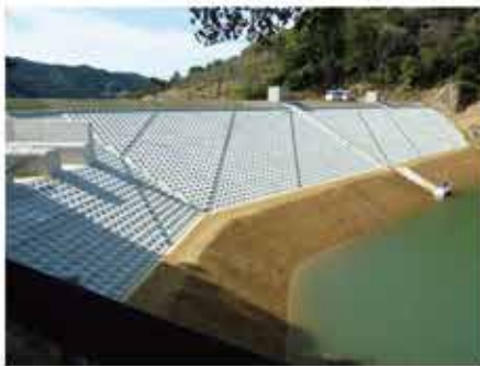
老朽化したため池の改修
