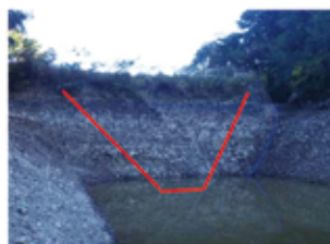
堤体をV字形にカットすることで貯水しなくする廃止工法
