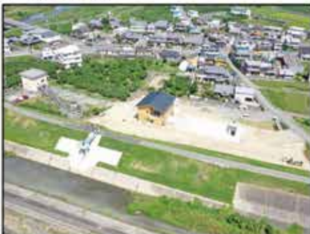
令和5年度供用開始した高嶋排水機場 （紀の川市）
